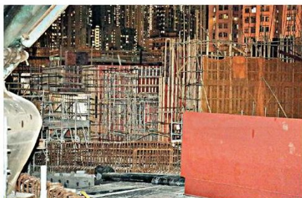
■建屋工程會動用大量的鋼筋。 (梁家裕攝)
