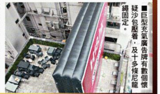
巨型充氣廣告牌鄰近民居及主要交通幹道，若發生火警後果堪虞。
