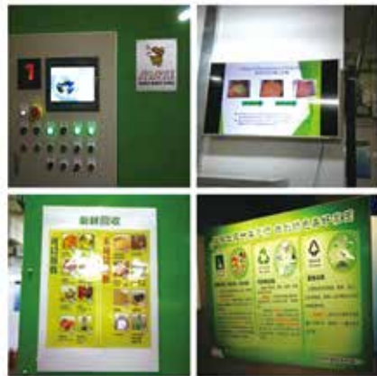
存冰制冷系统
