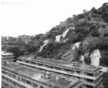
Plate 2: Shek Kip Mei Landslide (August 1999)
